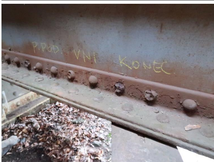
Foto č. 3 Konstrukce K 01 – pravý podélník – nýty oslabení
