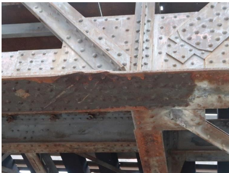
Foto č. 1 Konstrukce K 01 – levý hlavní nosník, dolní pásnice, 2. pole - deformace
