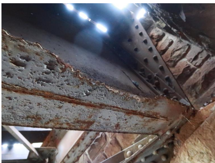
Foto č. 2 Konstrukce K 01 – polopříčnick nad O 02 – oslabení do ostra
